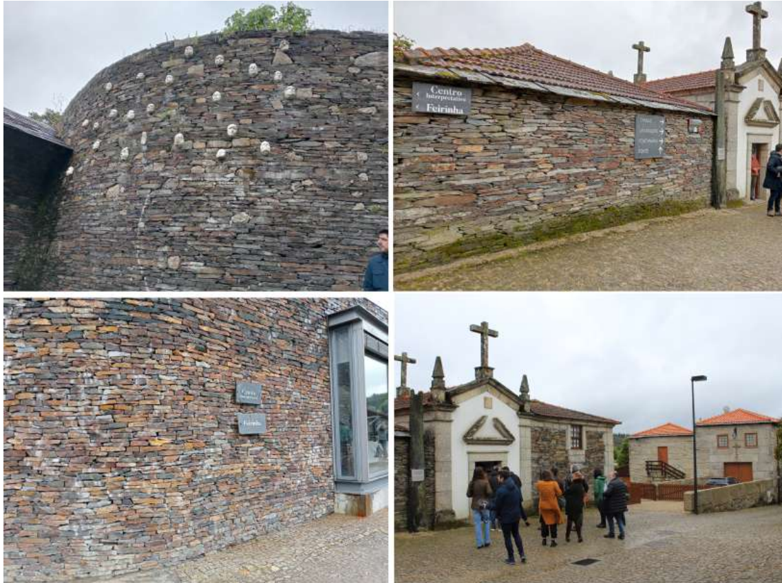
Aspetos da reabilitação do edificado e espaço público
