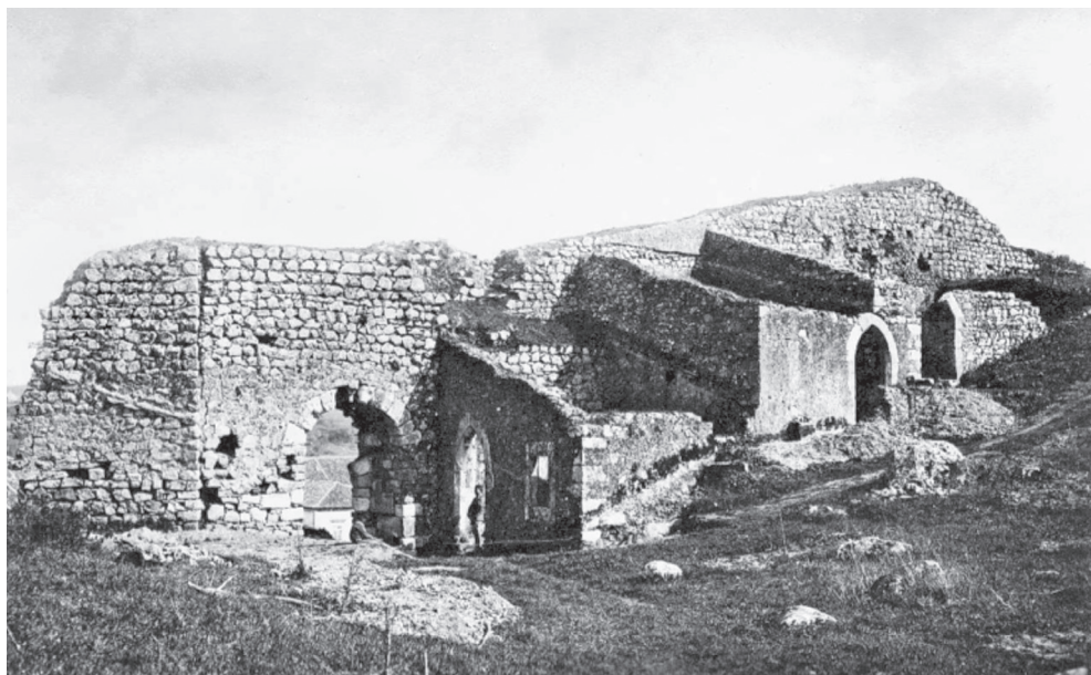
Antigas casas medievais em ruína, no castelo de Leiria (foto de cerca de 1900)
