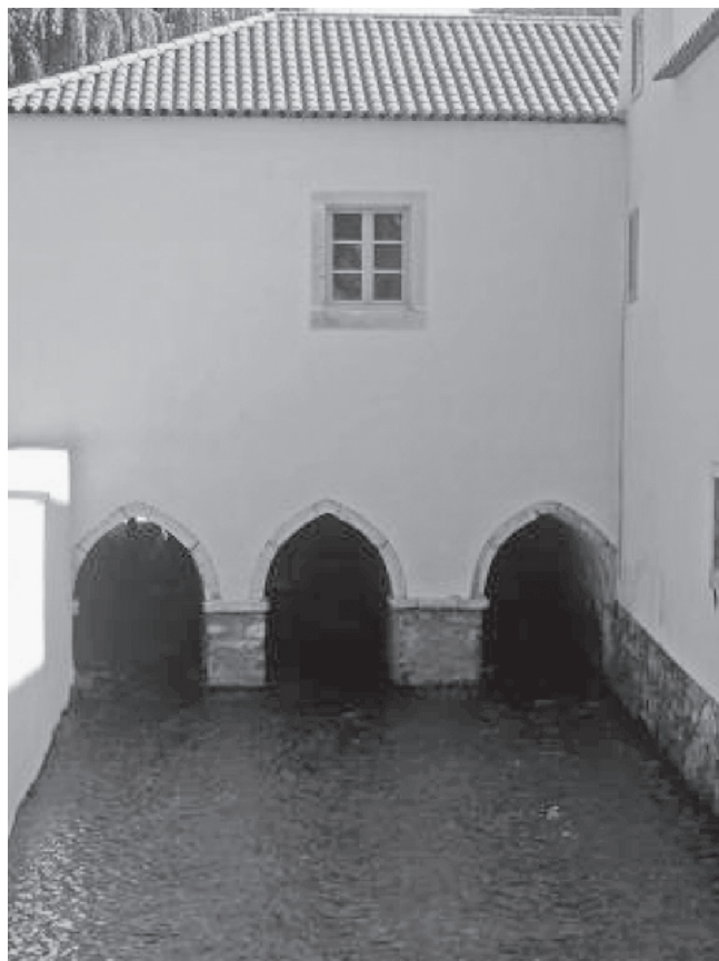
Antigo Moinho do papel, em Leiria: poços dos rodízios com aduelas de pedra calcária dispostas em arco gótico
