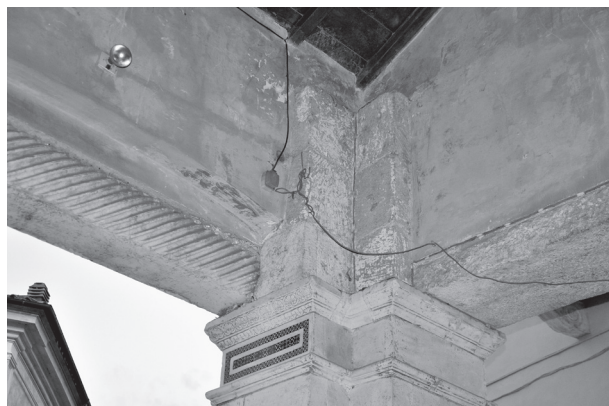
Fig. 2. Civita Castellana (VT), Cattedrale: particolare del portico antistante la facciata con architrave costituito da una colonna tortile di reimpiego.
