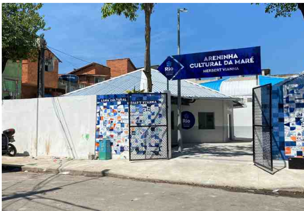
Figura 1: Entrada da Areninha Cultural Hebert Vianna, Maré, Rio de Janeiro, 2023. Fonte: Acervo particular
