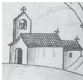
Cobertura de telha
