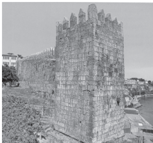
Figura 5. Restos da muralha gótica do Porto
